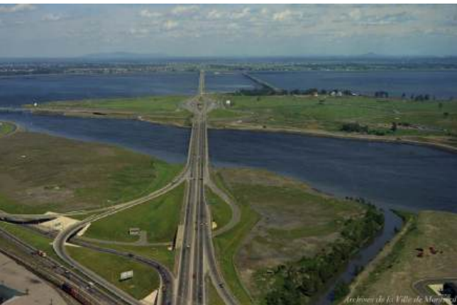
Construction du pont Champlain dans les années 1960
