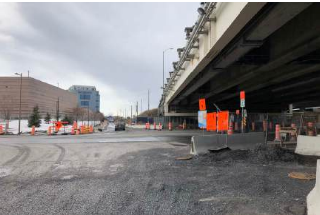
Bretelle d'accès A-15 sud
