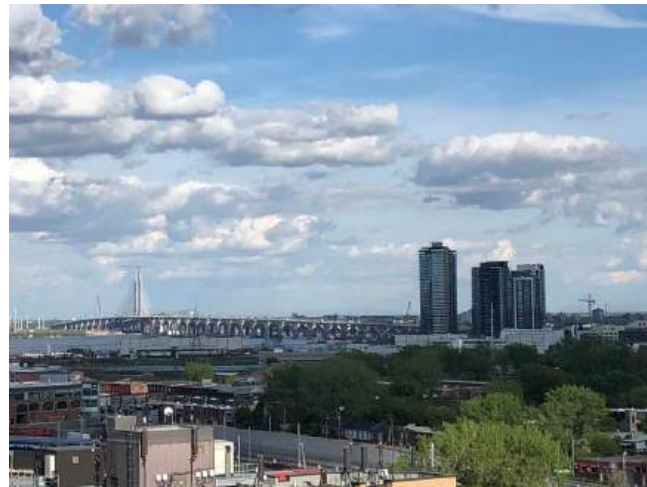
Les tours Évolò du quartier Pointe-Nord et le nouveau pont
