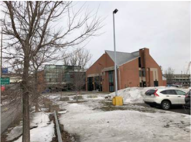
Trottoirs manquants le long du boulevard René-Lévesque
